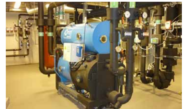
Abbildung 50: Technikraum mit AKA
